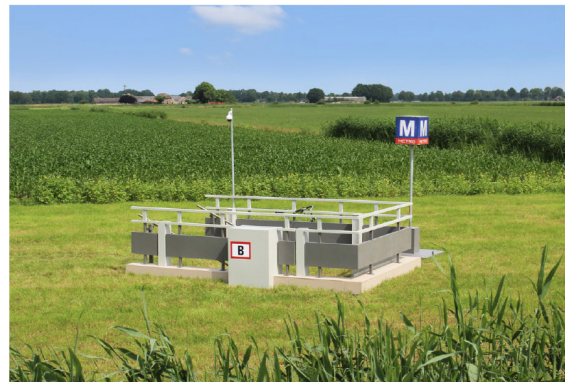
Metro Station Eekteweg (2018)
